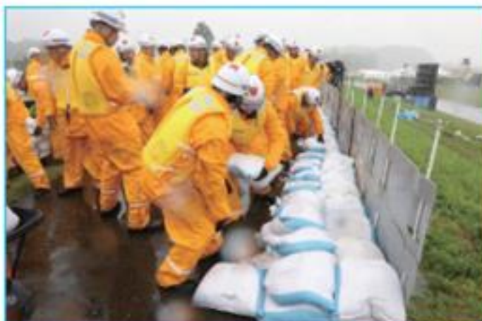
改良積み土のう
