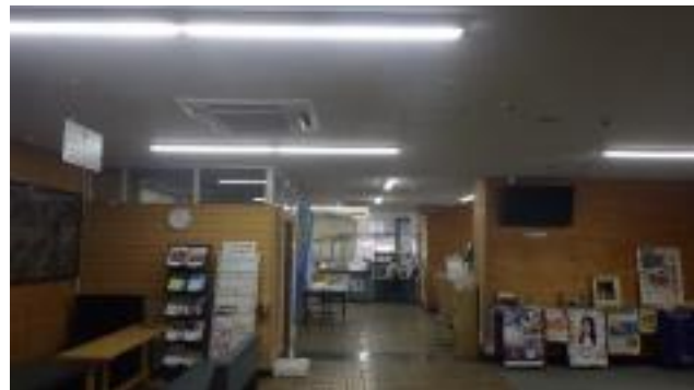
○高効率照明設備
