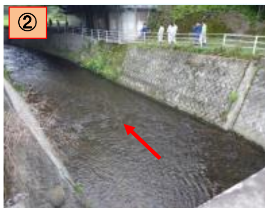
②鹿沼土木の点検状況(5/19) 一級河川思川(鹿沼市北半田)
