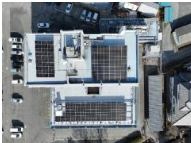
○太陽光パネル
