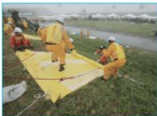
水防マット工
