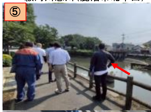
⑤栃木土木の点検状況(5/29) 一級河川巴波川(栃木市)
