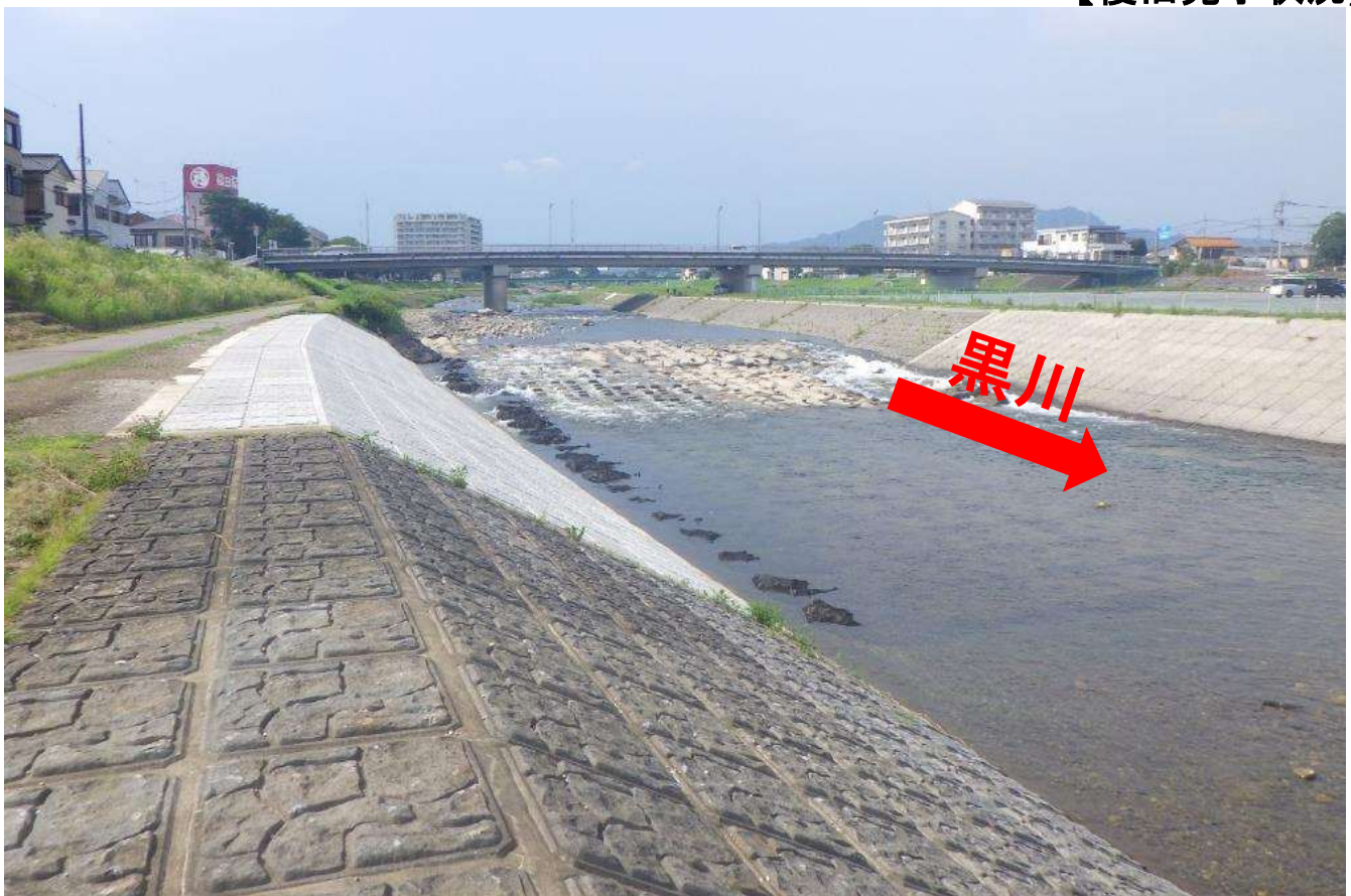
【復旧完了状況】
