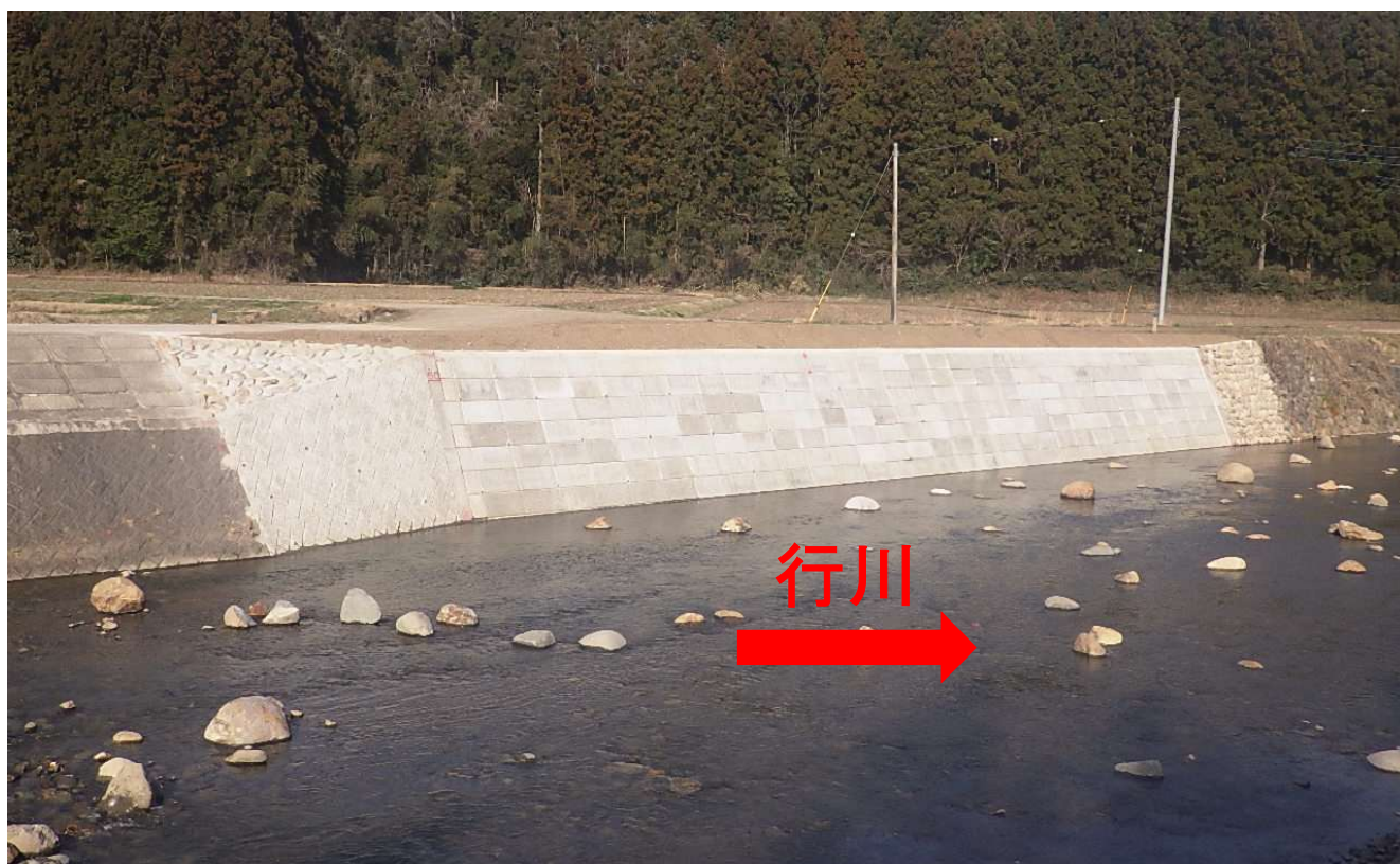
【復旧完了状況】
