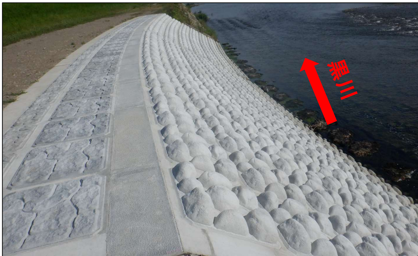
【復旧完了状況】
