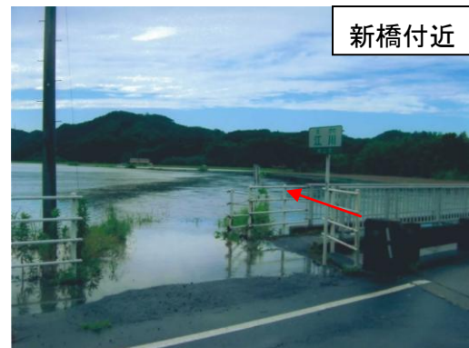
新橋付近 平成14年7月洪水時の江川（烏山）出水状況
