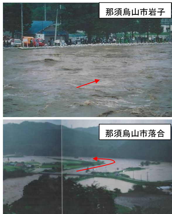
平成10年8月の出水状況
