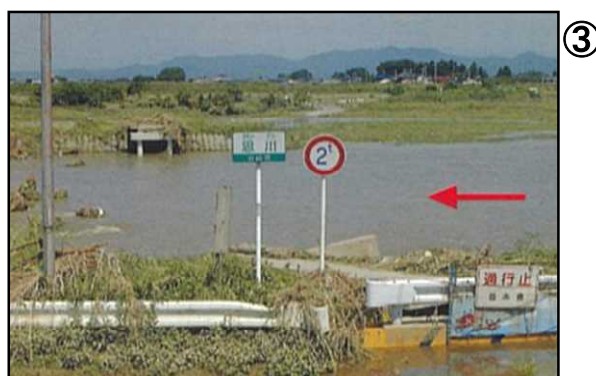
流出した間中橋【平成14年7月】 (小山市間中橋)
