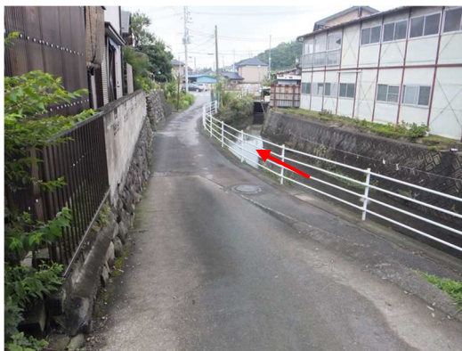
小藪川平常時の状況 (県道鹿沼日光線橋上流)
