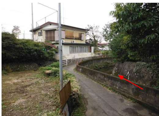
小藪川平常時の状況 (市道渋染橋下流)
