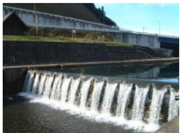
農業用水を取水している だんじょうせき 弾正堰(逆川)
