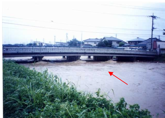
秋山川の出水状況【平成13年9月】 ( おおはし 大橋上流付近)
