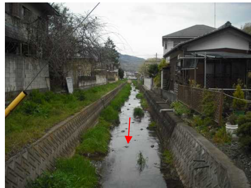
蓮台寺川 (三重橋より約 600m 上流付近)
