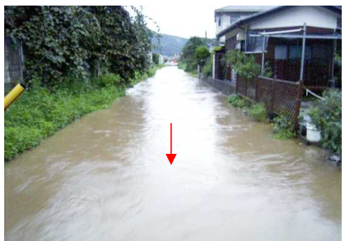
蓮台寺川の出水状況【平成20年8月】 みえばし(三重橋より約600m上流)
