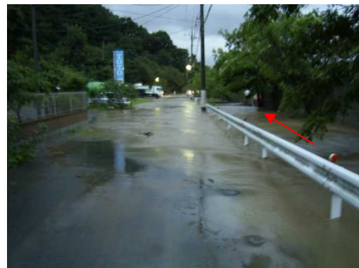
蓮台寺川の出水状況【平成 20 年 8 月】 (三重橋上流付近)
