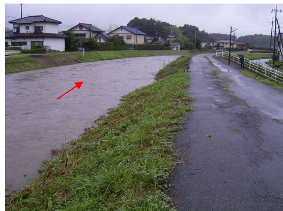
名草川の出水状況【平成18年7月】 みやまえばし (足利市宮前橋下流付近)
