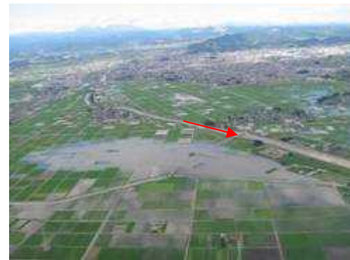
秋山川の浸水状況【平成14年7月】 (渡良瀬川合流付近)
