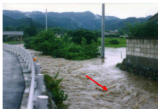
栗谷川の出水状況【平成12年7月】 あいおいばし （相生橋上流付近）
