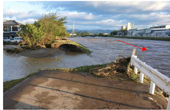
秋山川の出水状況【令和元年10月】 （佐野市大橋上流）
