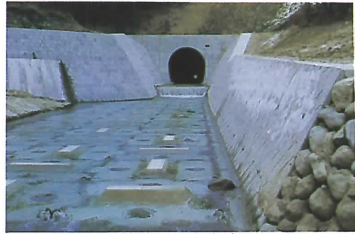
導水路トンネル吐口部
