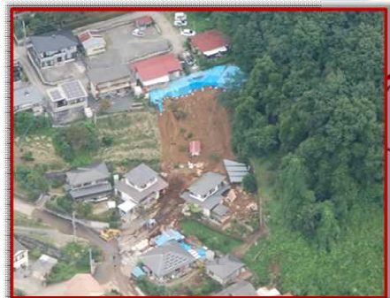
がけ崩れ 鹿沼市 日吉
