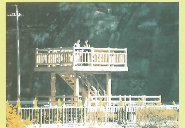
左岸上流展望台
