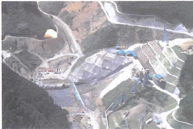
③H4.8 基礎掘削完了
