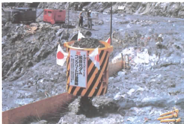
④H4.8.27 堤体コンクリート初打設
