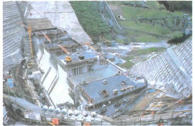
⑥H5.7 堤体状況
