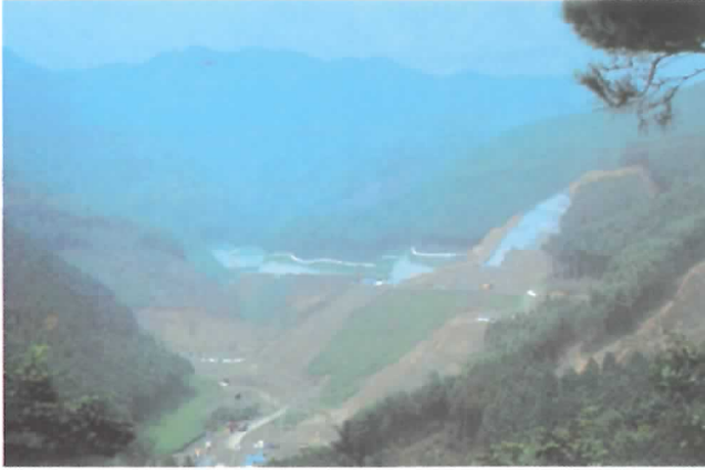
①H3.9 基礎掘削状況
