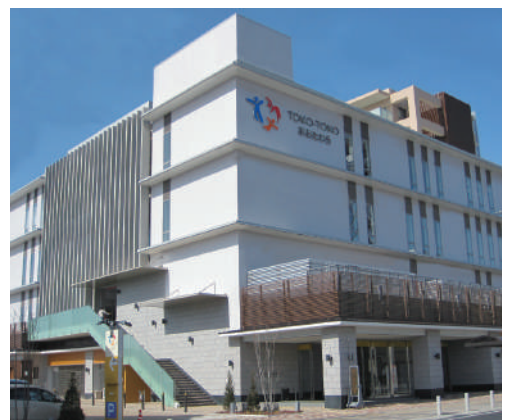
中央通り地区市街地再開発事業 (大田原市)
