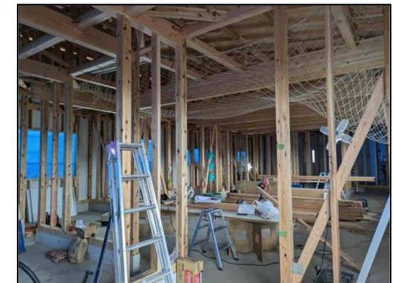
↑ 躯体施工状況 市産材である八溝杉を柱として使用
