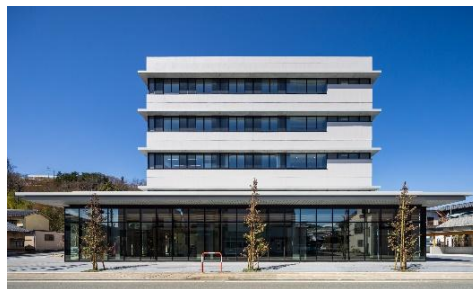
富士川地方合同庁舎
