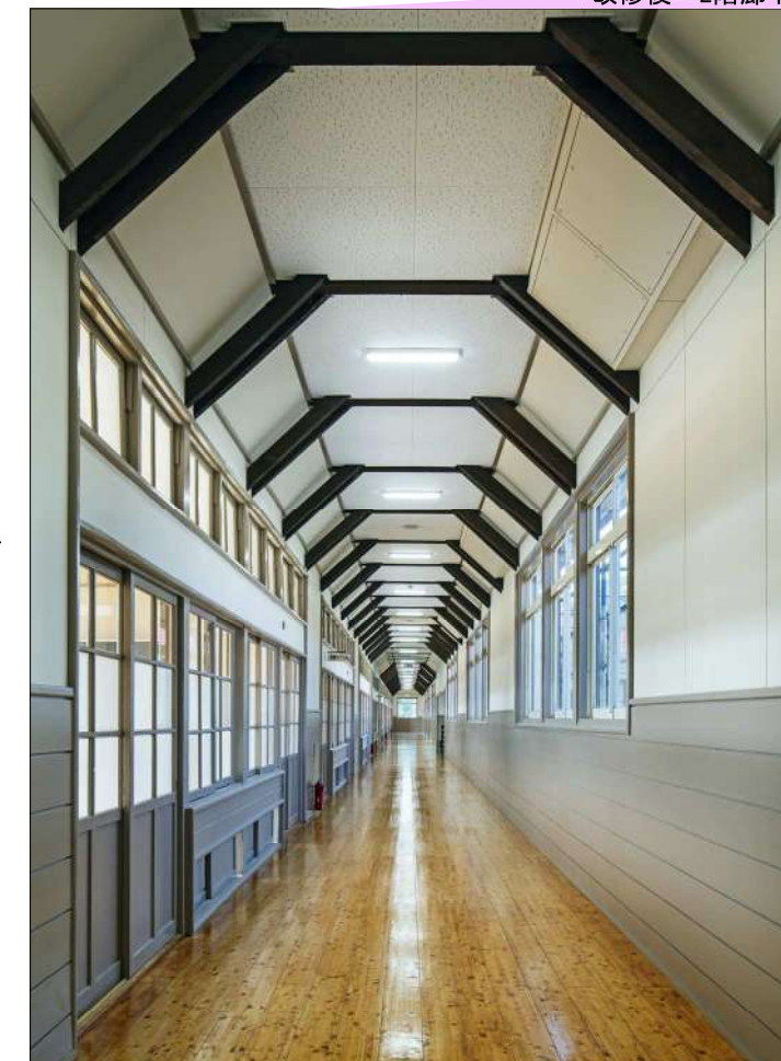
改修後 2階廊下
