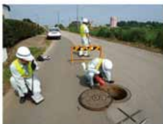
管路施設の緊急点検
