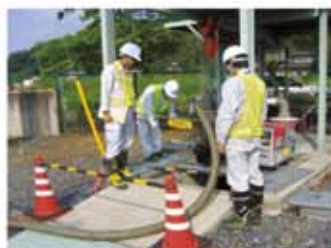
汚水溢水時のポンプによる仮排水
