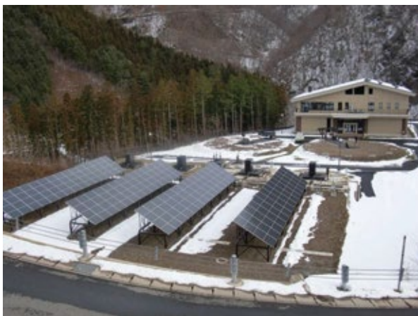
日光市湯西川水処理センター
