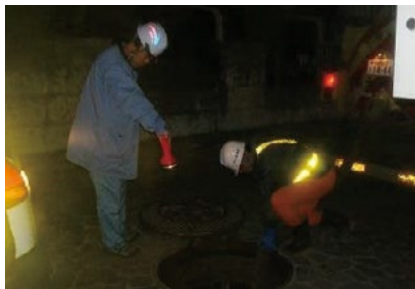
吸引車の使用による溢水防止のための水替え作業
