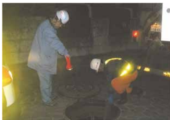
吸引車による溢水防止のための水替え作業
