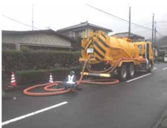
吸引車による溢水防止のための水替え作業
