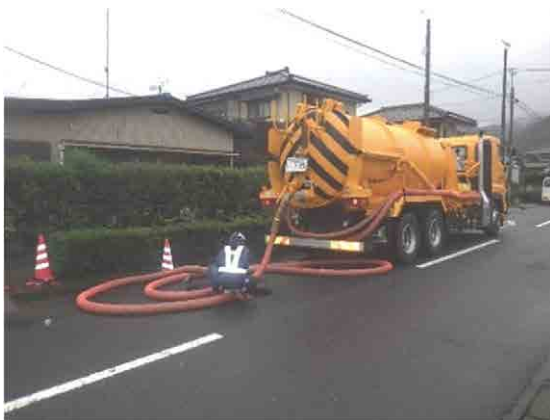
吸引車の使用による溢水防止作業
