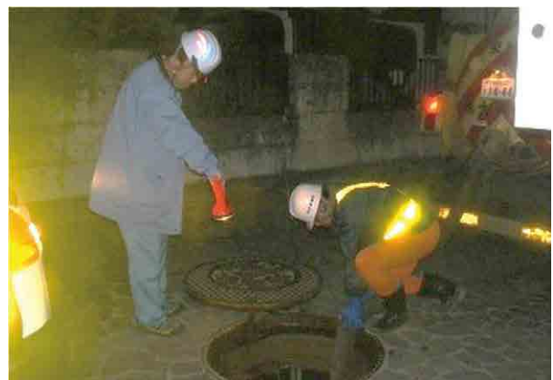
吸引車の使用による溢水防止作業
