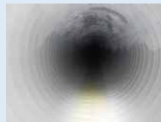
管更生対策後
