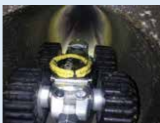
老朽化状況の調査
