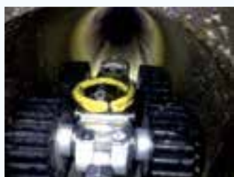
老朽化状況の調査
