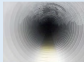
管更生対策後
