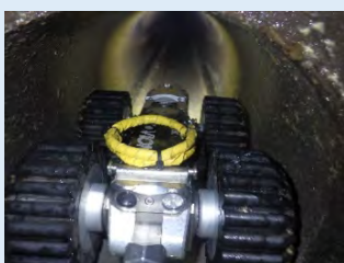
老朽化状況の調査
