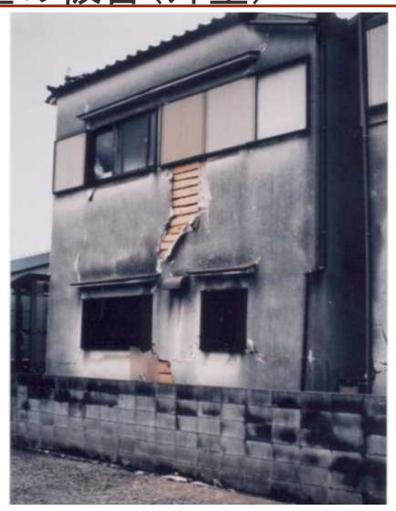
モルタル壁の大きな剥落 (**この面のみ**) ⇒ Bランク
