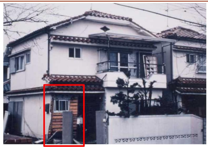
モルタル壁の大きな剥落 (**この面のみ**) ⇒ Bランク
