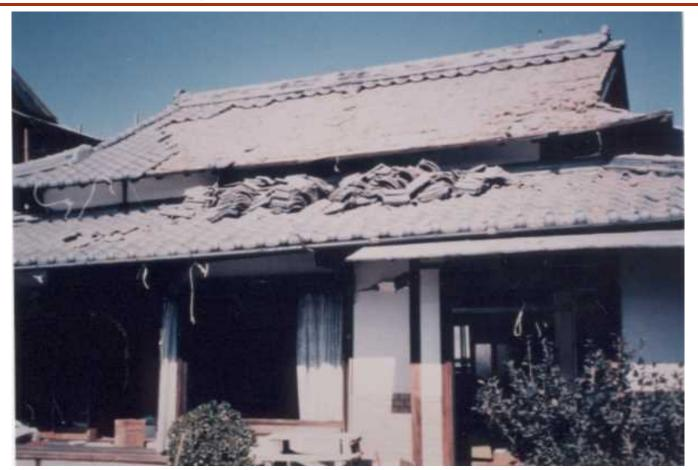
本屋根の瓦が下屋の方へずれてきて、下屋の方に固まっている。今にも落ちそうではないが、安全でもない。 Bランク
