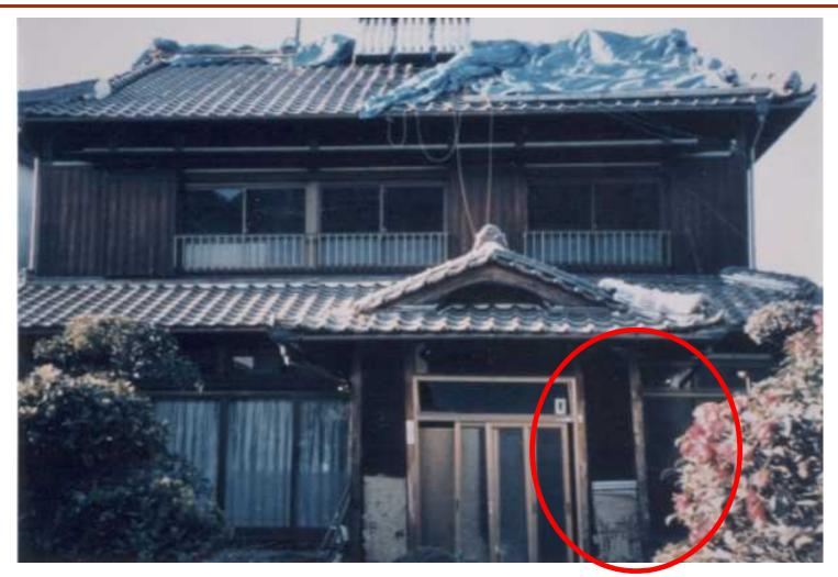
左側:ほとんど傾斜無し。2階の一部を支えているとみられる玄関付近、右側が大きく傾斜 Bランク
