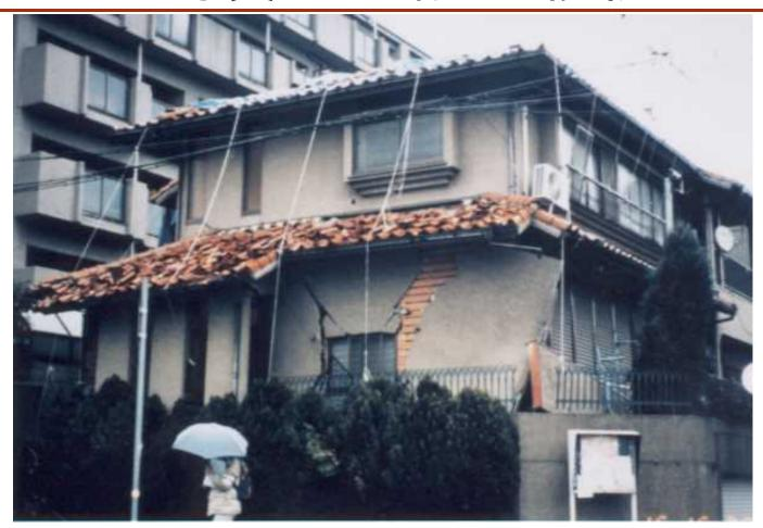
瓦のずれが著しく、今にも落下しそう。 瓦の落下により怪我をする可能性が高い。 Cランク
