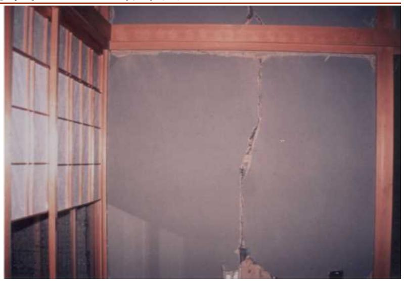
湿式壁の大きな亀裂・一部剥落(この面のみ): B
