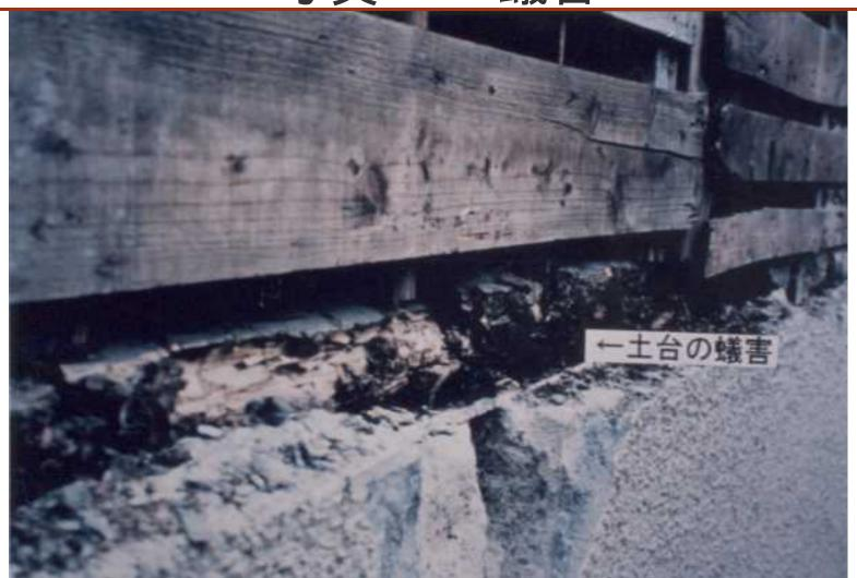
外壁モルタルが落下して下地が確認できた。著しい 土台の蟻害。「腐食・蟻害の有無」は Cランク
