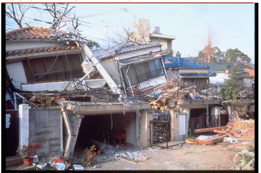
元は3階建の建物。1階RC(CB?)造、上階W造
