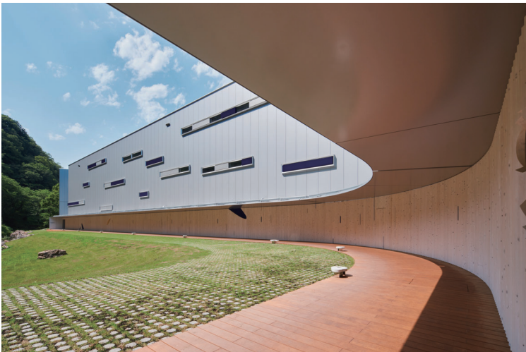
外部歩廊とロックガーデン。新生産工場M1外装のリズミカルに配置されたホリゾンタルスリット。歩廊の底は、アルミハニカムパネル仕上げで、軒高は2,675mm。
