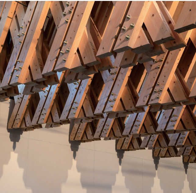
□ラーニングcommonsの木架構
