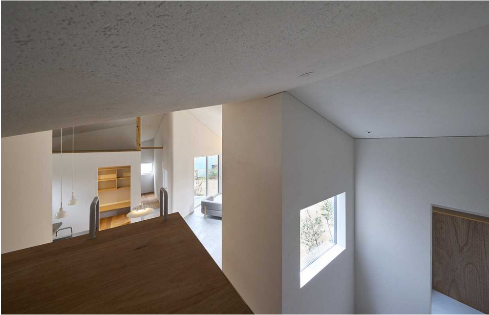
天井高さが一様でない内部。天井と壁は左官材で仕上げ巣屈感を出している。
