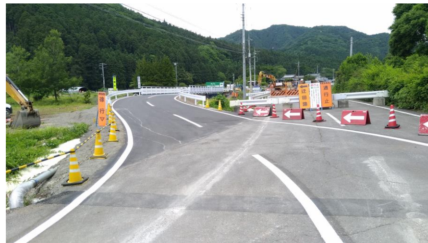
迂回路と本線との分岐部(一級河川 永野川左岸側)
