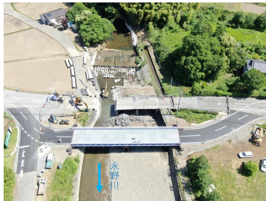
供用開始と同時に久保田橋の旧橋撤去を開始
