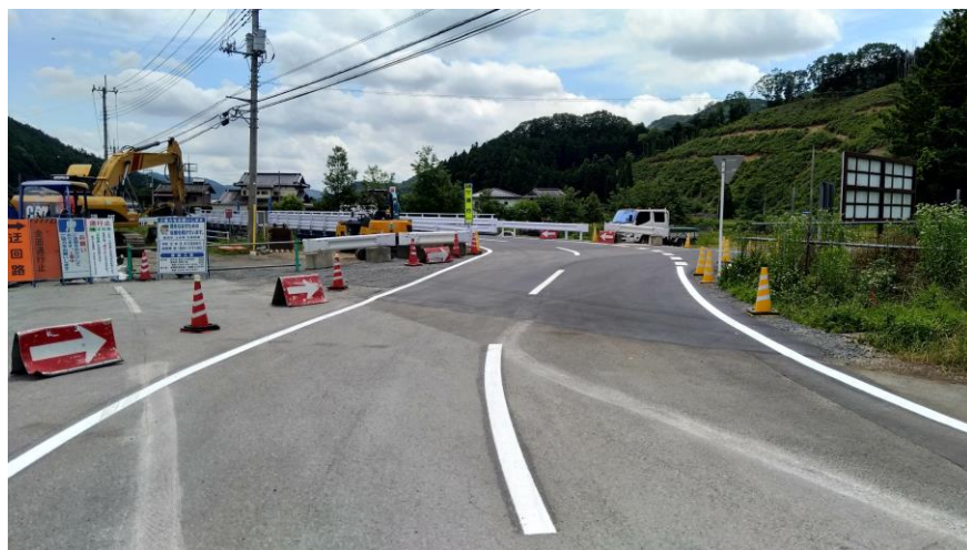
迂回路と本線との分岐部(一級河川 永野川右岸側)
