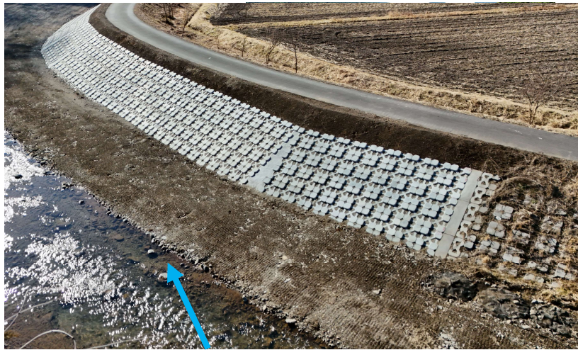
コンクリートブロック張工を実施
