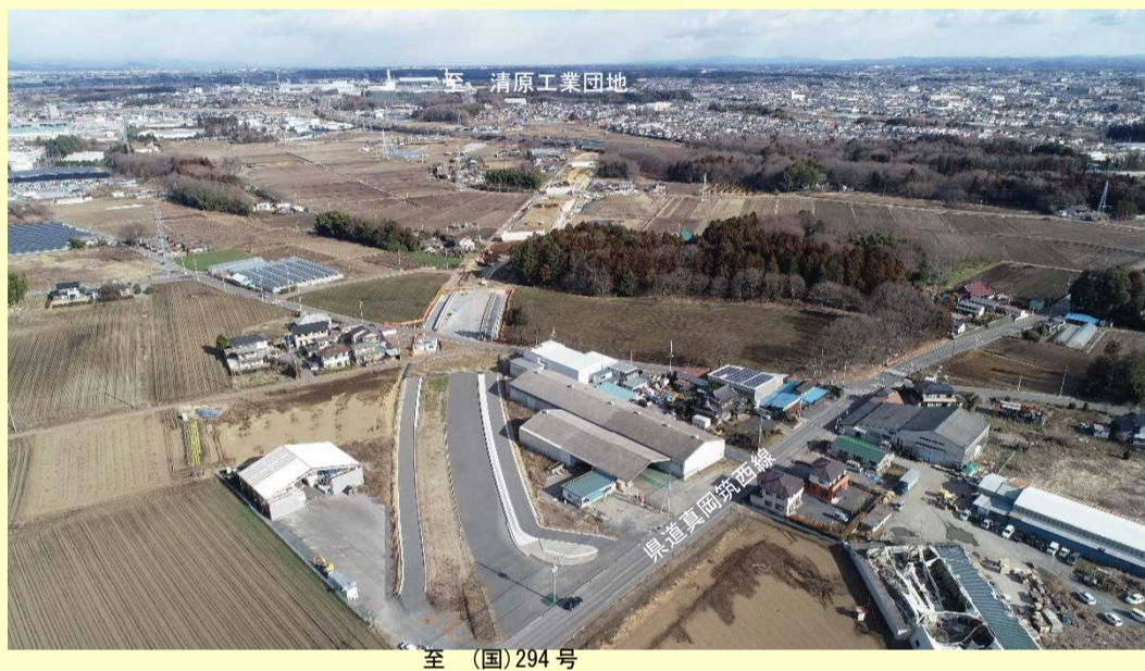
② 県道真岡筑西線付近
