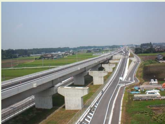
清南大地高架橋付近
