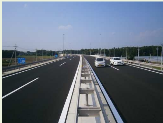
(一)井頭公園線付近
