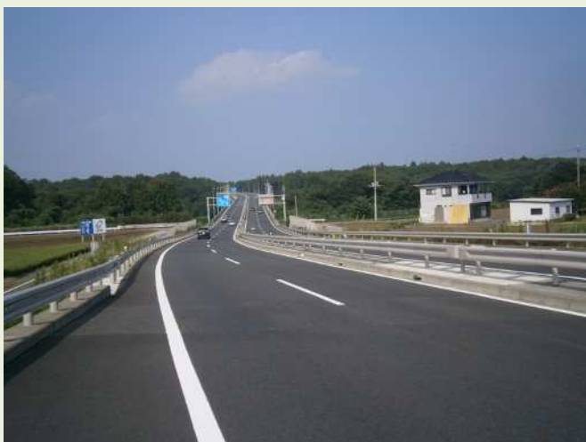
真岡もめん大橋付近
