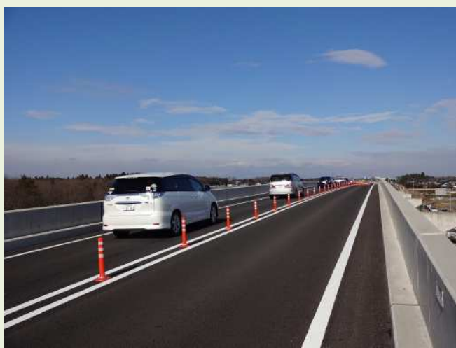
清南大地高架橋付近
