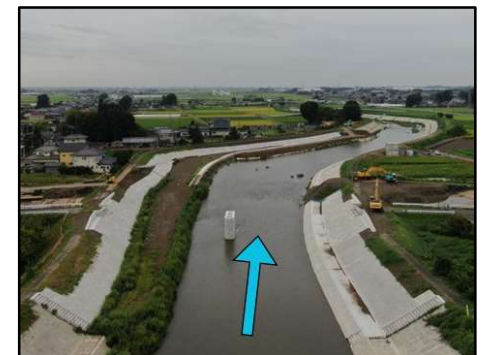
永野川 両明橋 下部工施工状況
