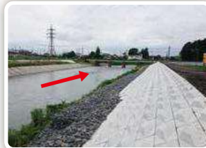
応急工事完了
