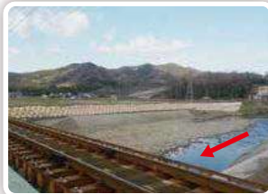
応急仮工完了
