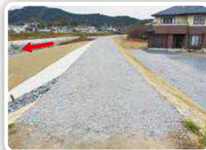
応急工事完了
