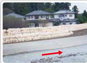
応急仮工完了
