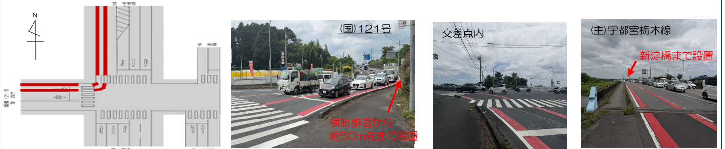
図-9：カラー区画線の設置状況
