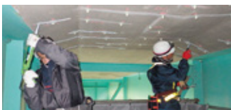
橋梁補修状況
