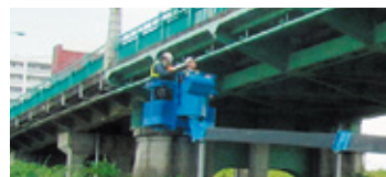
橋梁点検状況
