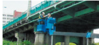
橋梁点検状況
