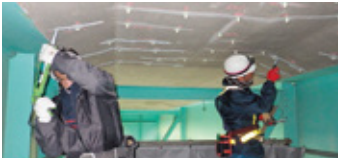
橋梁補修状況
