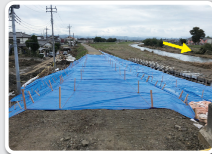
応急仮工完了
