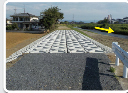
応急工事完了
