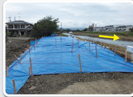
応急仮工完了
