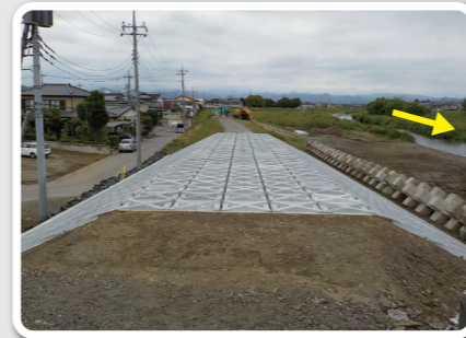
応急工事完了
