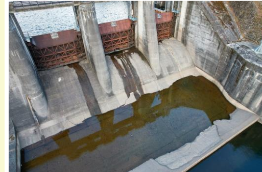
▲ ダム下流 コンクリート部の洗掘（摩耗）状況
