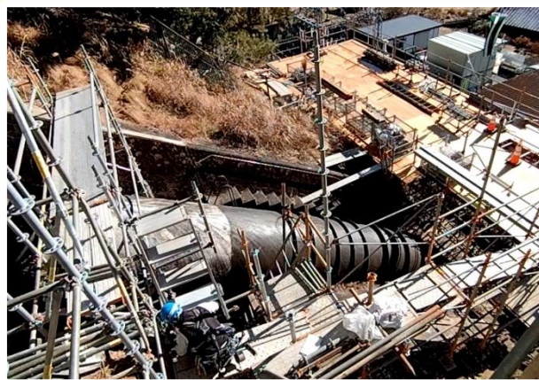
▲ 足尾発電所水圧鉄管耐震補強工事の状況（R6～7年度実施）▲
