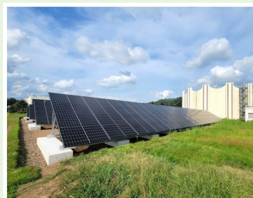
▼ 浄水場に設置した太陽光発電設備
