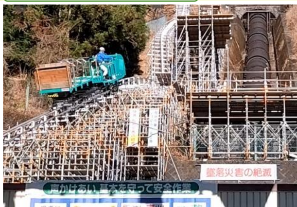
▲ 足尾発電所水圧鉄管耐震補強工事の状況（R6～7年度実施）▲
