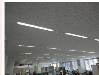
▲ 照明設備更新（LED化）
