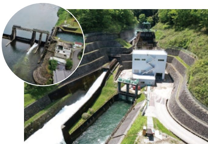
▲風見発電所と佐貫頭首工 県営発電所の中で最も使用水量が多い発電所です。佐貫頭首工から取水し、農業用水路の落差を利用し、発電しています。 リニューアル工事を経て、令和6(2024)年3月に運転を再開しました。
