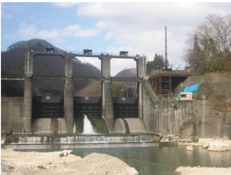
▲平成18(2006)年 小網発電所建設工事
