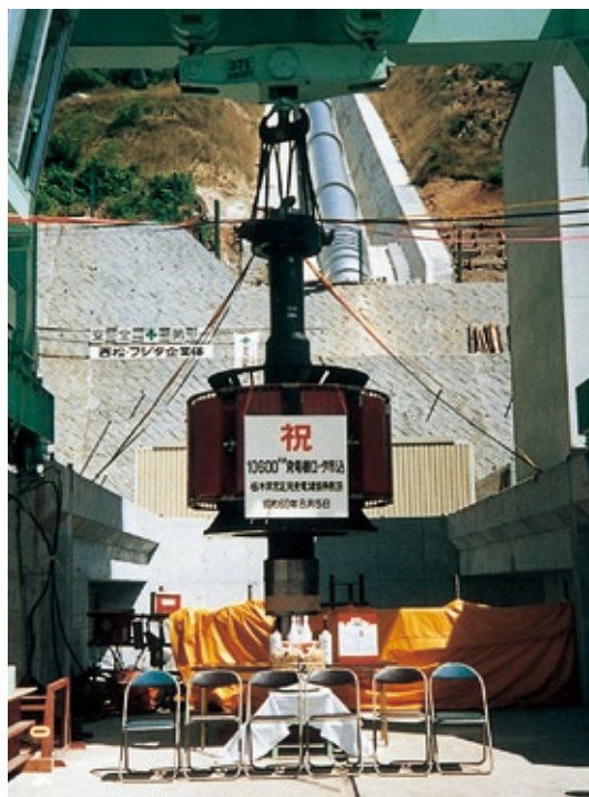
▲発電機ロータ吊込式 (昭和60(1985)年8月5日・足尾発電所)
