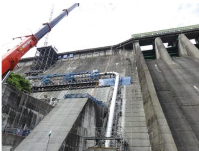
▲平成27(2015)年～ 五十里発電所建設工事
