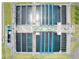
薬品沈でん池
