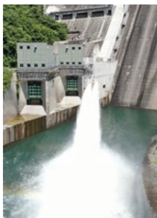
▲川治第二発電所と小網ダム 川治第一発電所で使用した水を小網ダムに貯めて発電しています。
