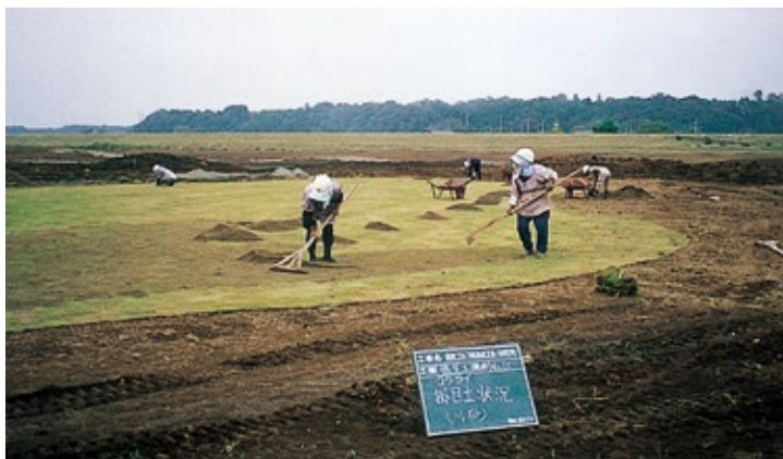
▲栃木県民ゴルフ場造成
