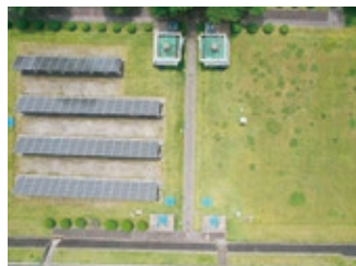
浄水池・調整池
