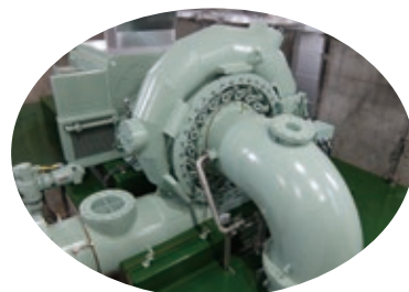
▲五十里発電所と水車・発電機 五十里ダムからの河川維持流量を利用し、令和2(2020)年5月に運転を開始した発電所です。
