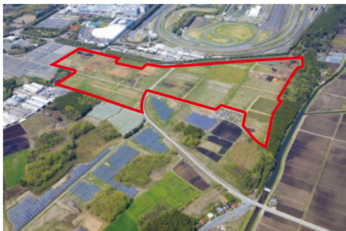
▲令和2(2020)年～令和4(2022)年 芳賀第2工業団地造成
