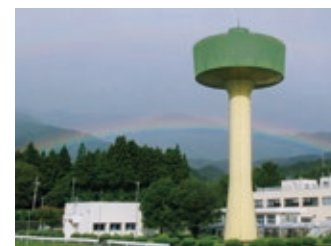
高架水槽・塩素混和池
