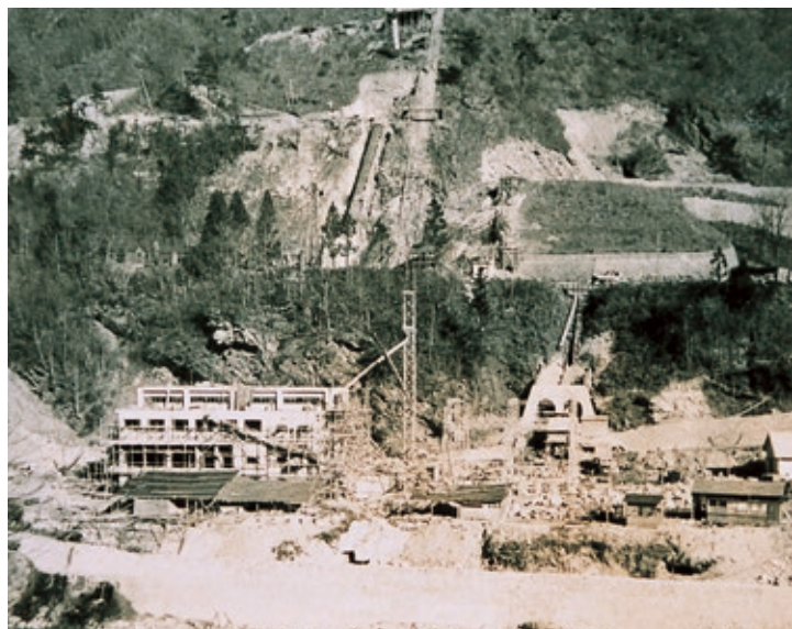
▲川治第一発電所建設工事全景
