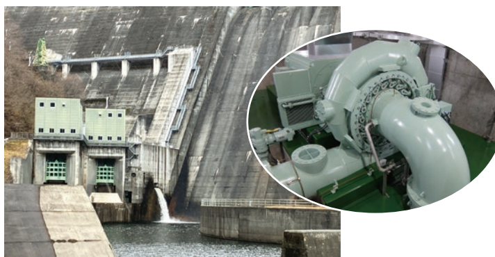
▲五十里発電所と水車・発電機 五十里ダムからの河川維持流量を利用し、令和2(2020)年5月に運転を開始した発電所です。
