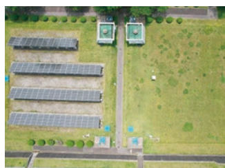
■浄水池・調整池
