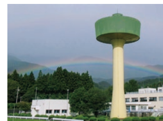
■高架水槽・塩素混和池
