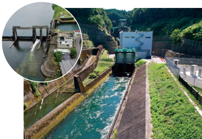
▲風見発電所と佐貫頭首工 県営発電所の中で最も使用水量が多い発電所です。佐貫頭首工から取水し、農業用水路の落差を利用し、発電しています。 全面改修事業を経て、令和6(2024)年3月に運転を再開しました。
