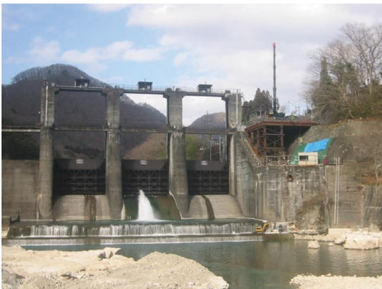
▲平成18(2006)年 小網発電所建設工事
