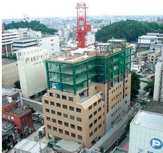
▲建設中の栃木県本町合同ビル
