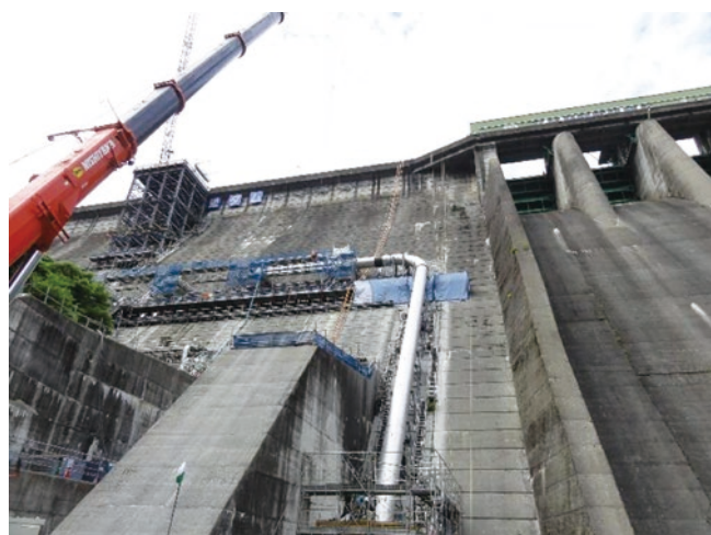
▲平成27(2015)年～ 五十里発電所建設工事
