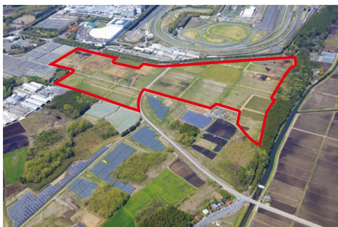
▲令和2(2020)年～令和4(2022)年 芳賀第2工業団地造成
