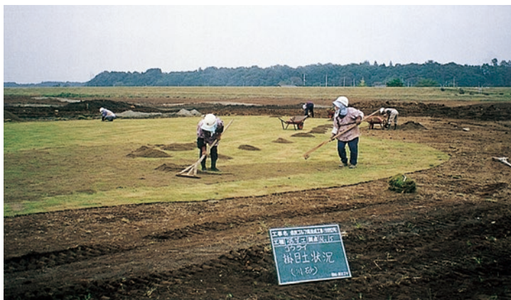
▲栃木県民ゴルフ場造成
