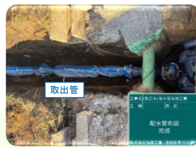
取出管の布設
