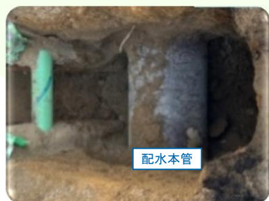
配水本管の露出
