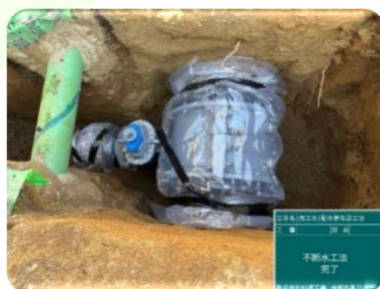
不斷水工法による取出管の分岐
