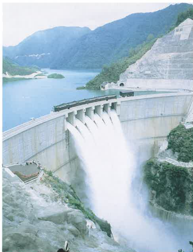
かわじ 川治ダム
