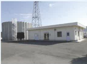
芳賀中部上水道企業団 (芳賀町受水地)
