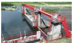
▲農業用水利施設(頭首工)の整備改修
