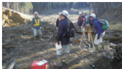
▲災害復旧に向けた測量
