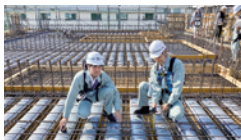
▲建築工事現場監督
