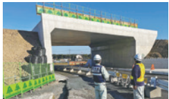
▲ボックスカルバートの工事立ち会い
