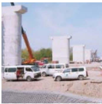
工事中の新鬼怒川渡河道路
