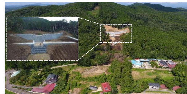
砂防堰堤の整備による土砂災害の防止
