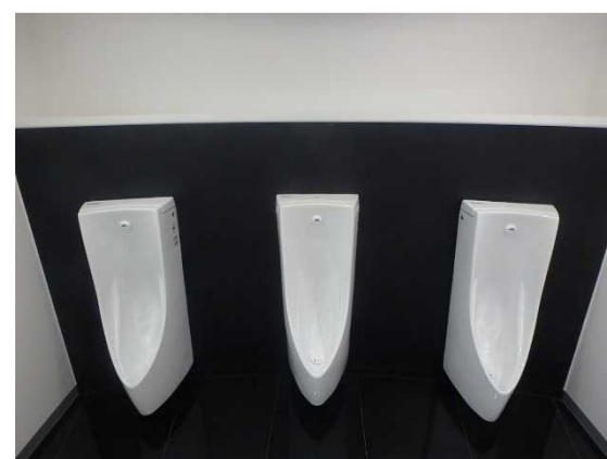
トイレ 改修後
