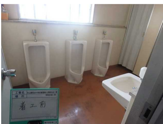
トイレ 改修前
