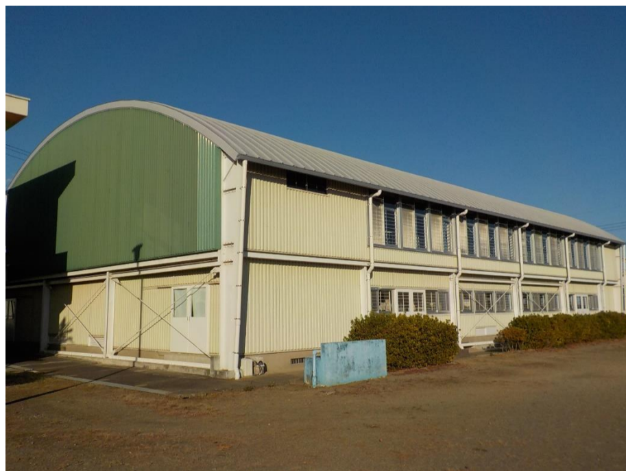
【改修後】 南西側外観
