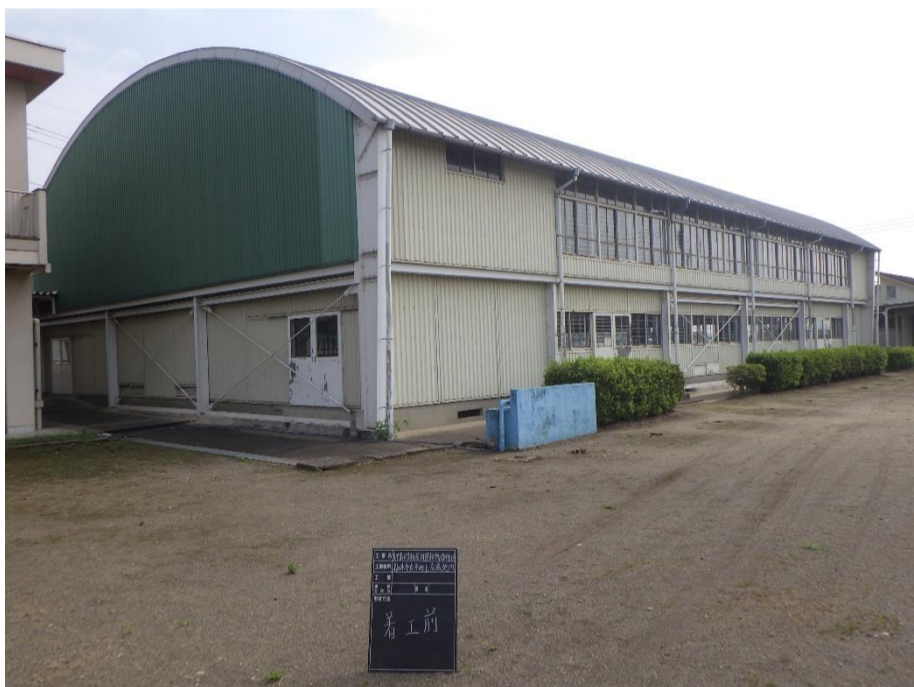
【改修前】 南西側外観
