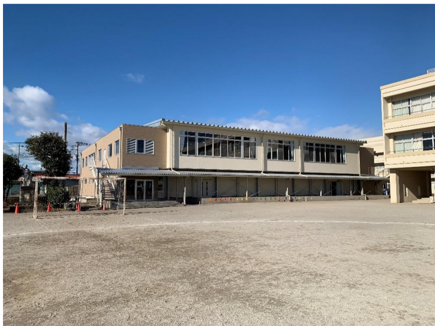
改修後 東側外観
