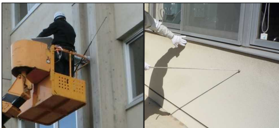
<外壁打診調査状況>
