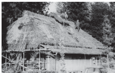
結によるかやぶき屋根のふきかえの様子 (昭和期 那須塩原市(旧西那須野町) 那須塩原市那須野が原博物館提供)
