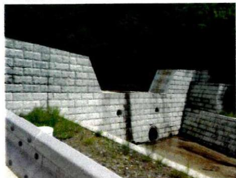
写真左＝完成した堰堤。場内から堆積物が崩落・流出した時、一時的に受け止める。住民の避難の「時間稼ぎ」となる。
