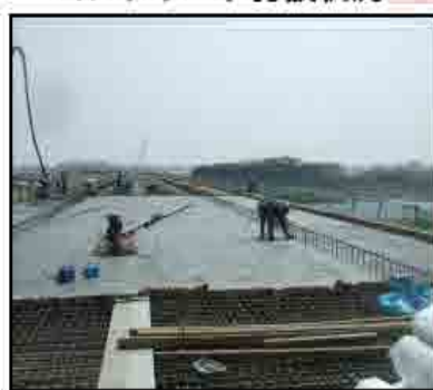
コンクリート打設状況
