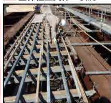
型枠組立支保工状況
